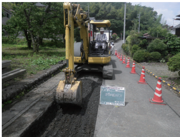
開削工法による污水管整備（青梅市）
