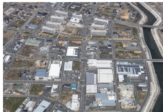
区画整理完了後
