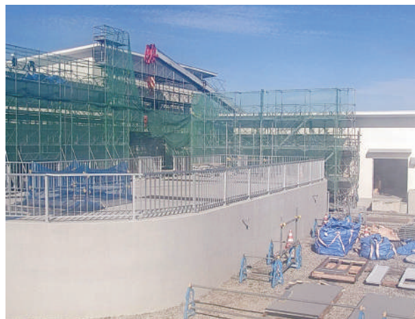
水再生センターの施工状況（新島村・式根島）
