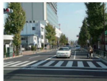
無電柱化整備後
