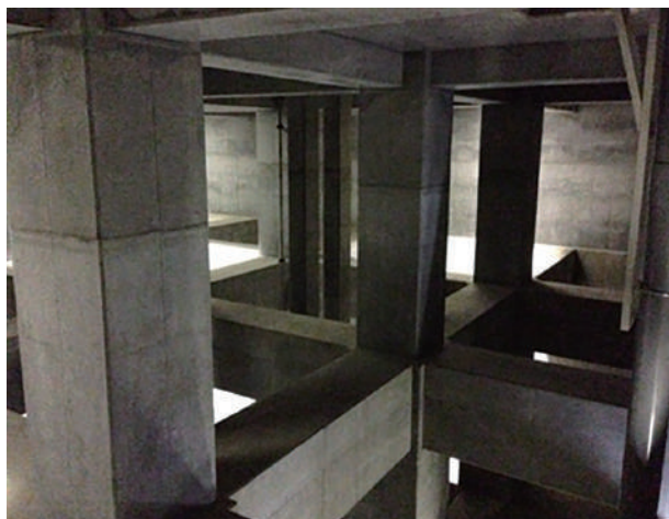
一時貯留施設の設置状況（武蔵野市）
