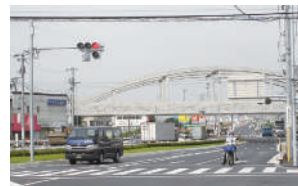
JR 南武線連続立体交差事業(矢野口駅付近)
