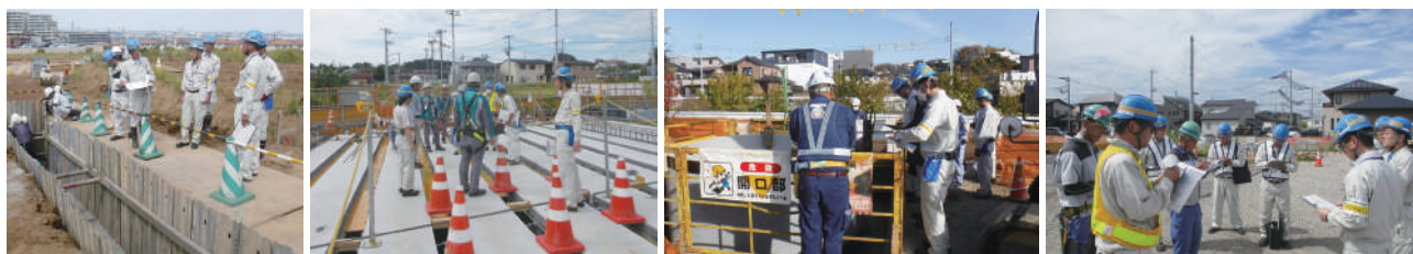
現場総点検の実施状況
