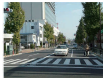
無電柱化整備後
