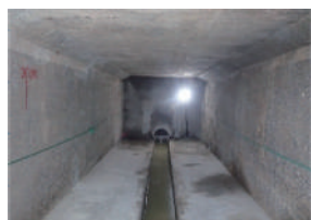
ストックマネジメント（施工前）
