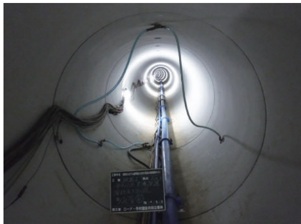
泥濃式推進工法による内径2200mmの雨水管施工状況（清瀬市）
