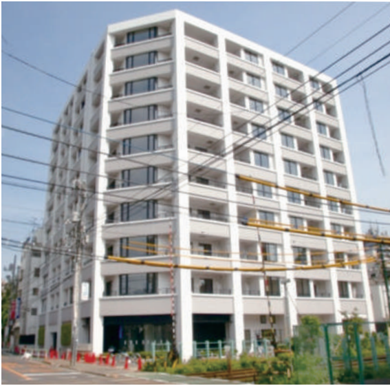
東池袋地区代替床施設
