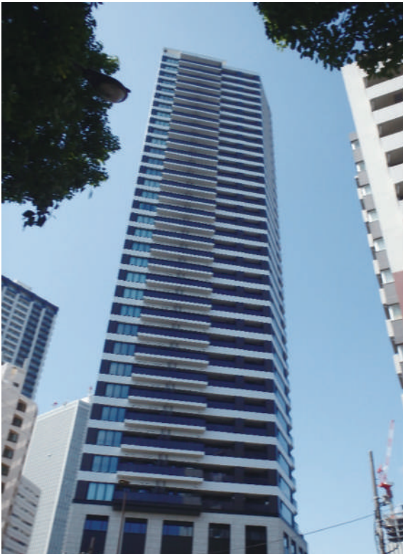
東池袋四丁目2番地区第一種市街地再開発事業 (プラウドタワー東池袋ステーションアリーナ)
