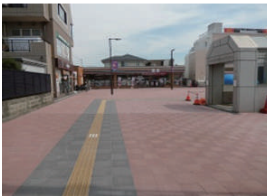
スタジアム通り歩道の遮熱性舗装 [スタジアム通り及び飛田給駅公共道路]※
