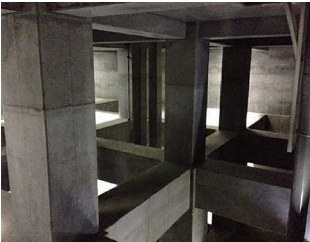
一時貯留施設の設置状況（武蔵野市）
