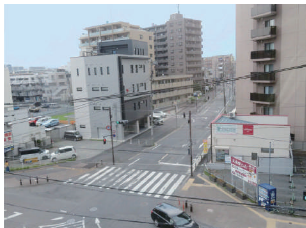
道路拡幅用地取得後
