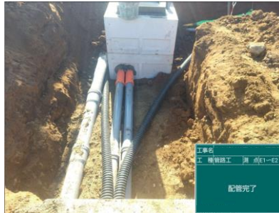
ハンドホールに管路を接続します
