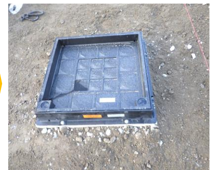
金蓋を設置して、埋め戻して完了
