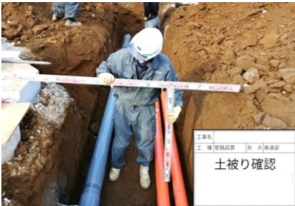
ケーブルを通す管路を敷設します
