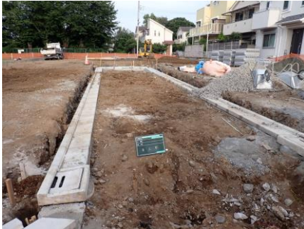
L型側溝が入った状態での着工前
