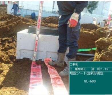
埋設シートを設置します
