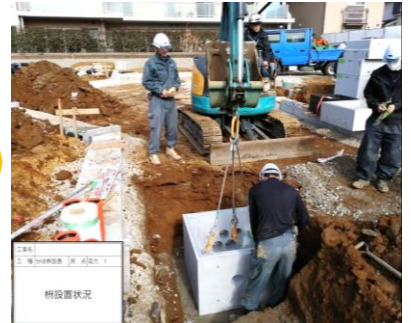
ハンドホールを設置します
