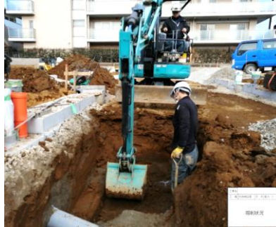
バックホウで掘削します
