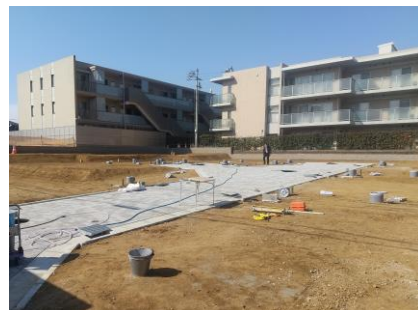
【完成した開発道路】
