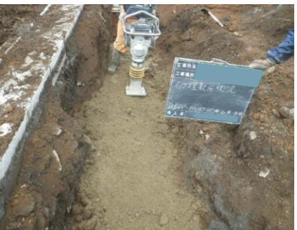
埋め戻し、転圧をします
