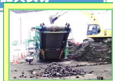
搬入土をバックホウで投入し稼動状態のトロンメル
