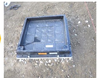
金蓋を設置して、埋め戻して完了
