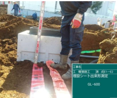
埋設シートを設置します
