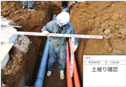
ケーブルを通す管路を敷設します
