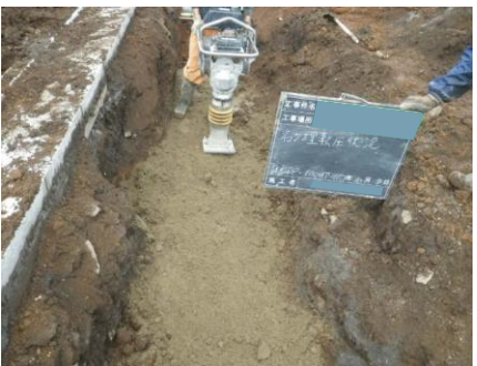
埋め戻し、転圧をします
