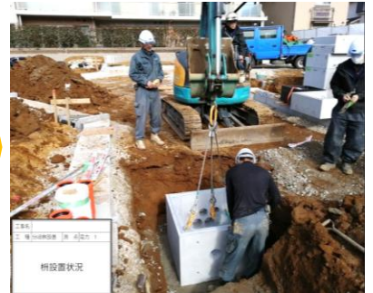
ハンドホールを設置します
