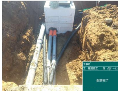
ハンドホールに管路を接続します
