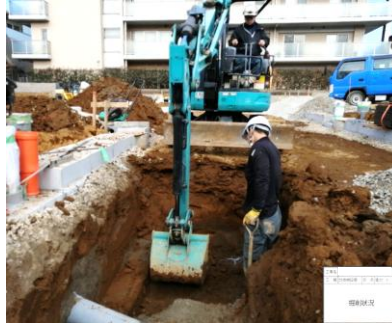
バックホウで掘削します
