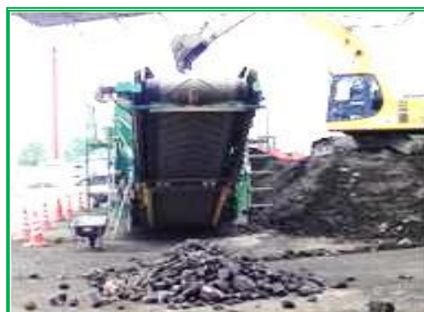
ガラ等の混入物の除去
