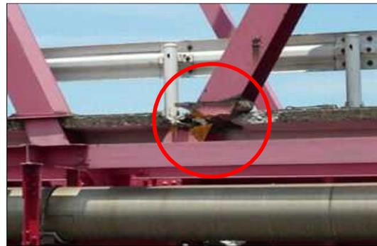
図 2-4 破断した橋梁
