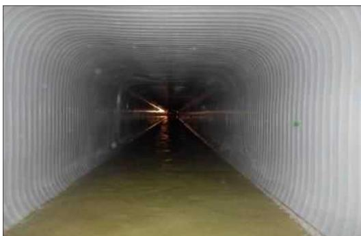
図 5-3 内面被覆による下水道管の更新
