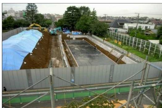
図 2-15 雨水貯留浸透施設の設置状況
