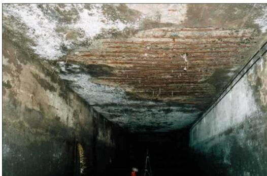
図 2-3 老朽化した下水道管
