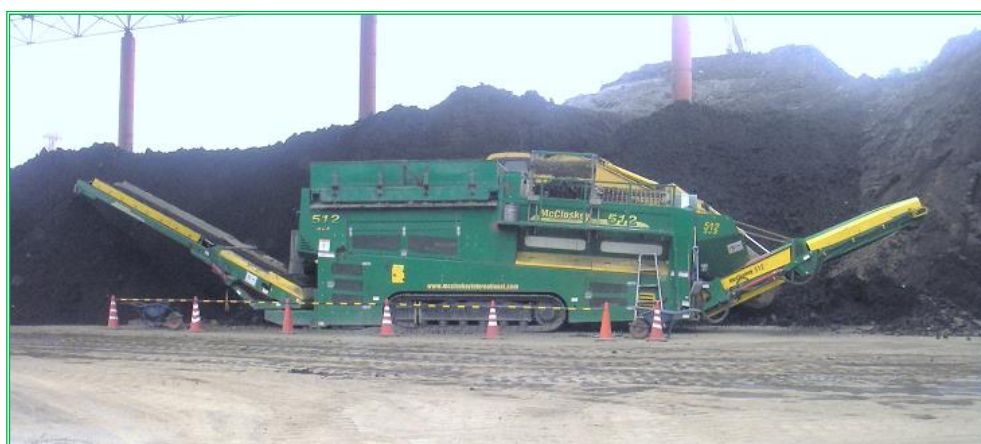
搬入土をバックホーで投入し稼働状態のマシン
