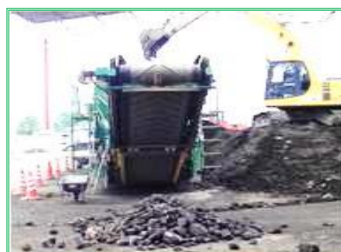
ガラ等の混入物の除去
